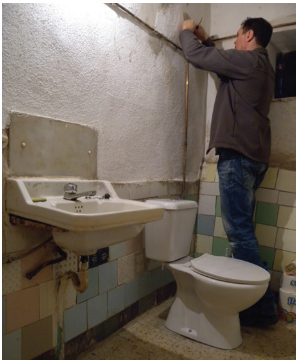
El «brigada d'emergència» acabant d'instal·lar un vàter nou a un habitatge.
