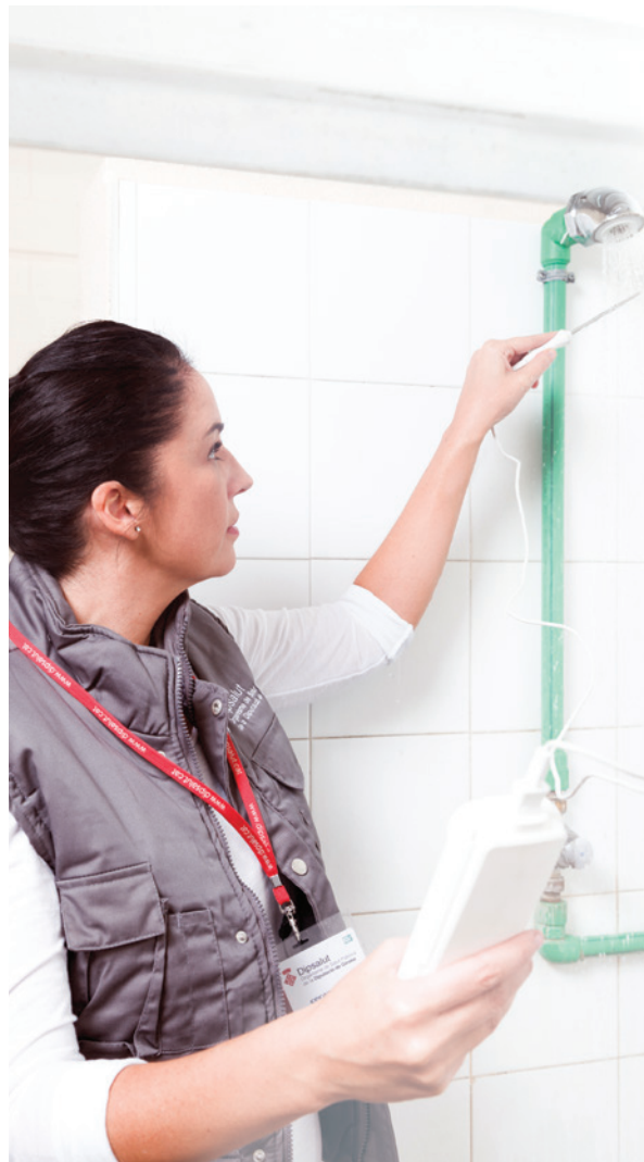
Comprovació de la temperatura de l'aigua a les dutxes d'un poliesportiu, dins del Programa de Suport a la Gestió i Control d'Instal·lacions d'Alt Risc de Transmissió de Legionel·losi. Autor: Àlex Tremps.
