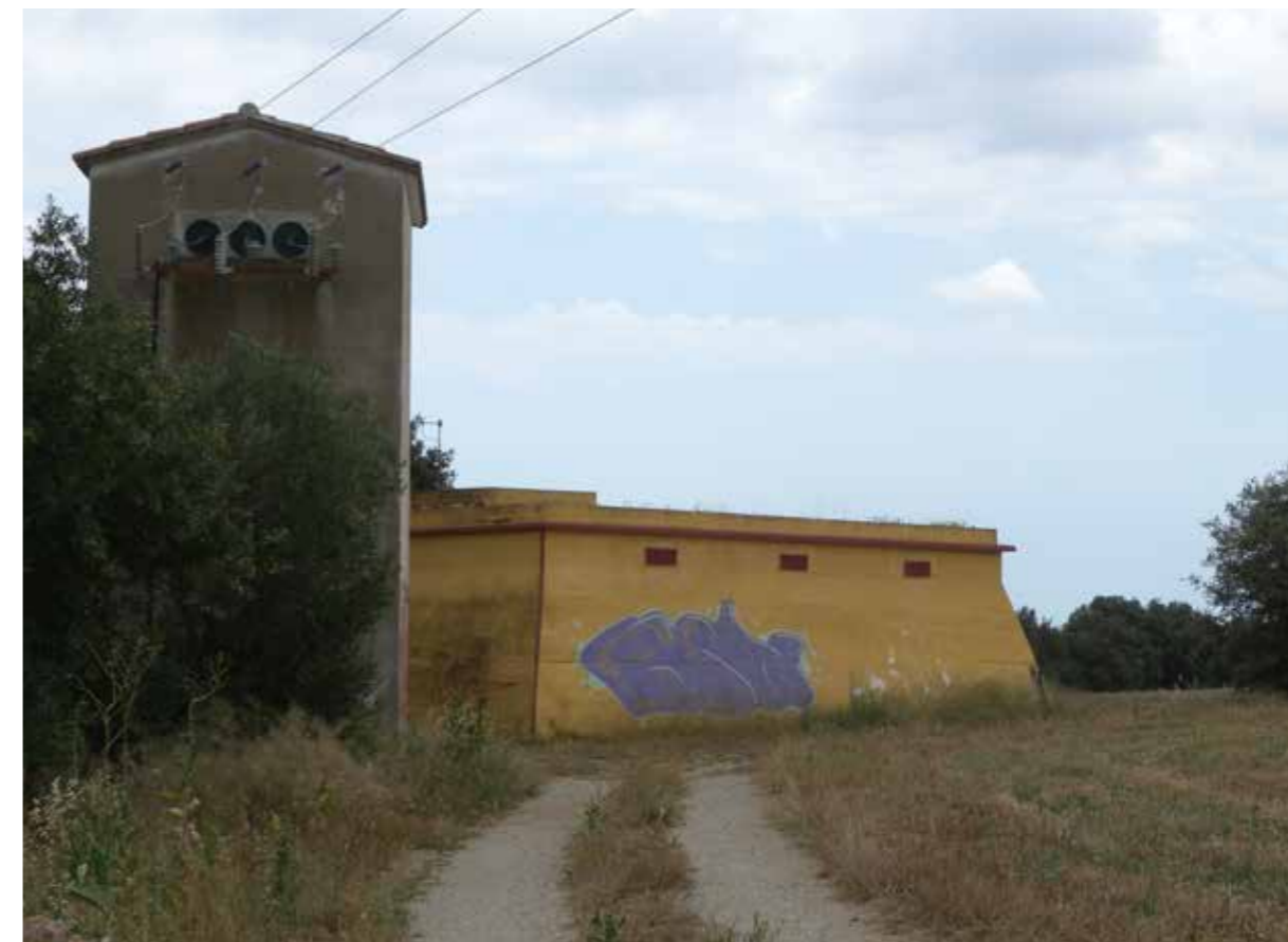
Dipòsit municipal de Borrassà, on s'instal·larà la planta d'eliminació de nitrats.
